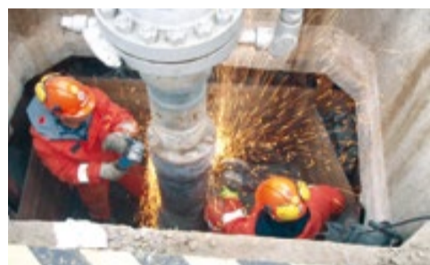
Pracovníci HBZS demontují staré ústí sondy V-2.
