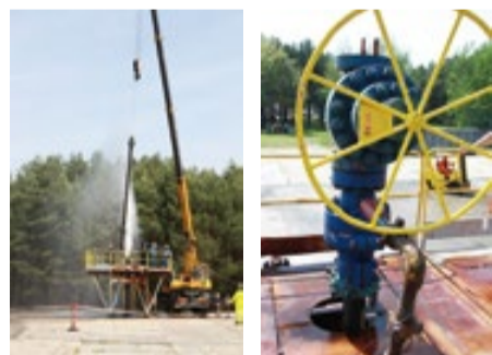
Odřezání pažnice pro montáž dělené příruby
