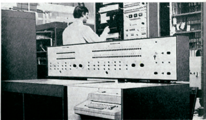
Příklad řešení mateřské stanice řídicího systému v plynárenském dispečerském centru. Snímky: archiv TP
