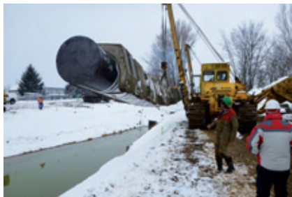
Oba horní obrázky: pokládání shybky do zaplaveného výkopu
