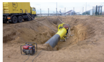
Tlakové zkoušky
